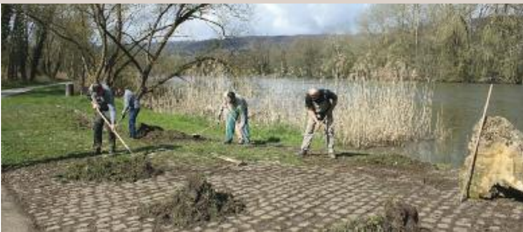
Mise au jour de l'ancien chemin de halage
