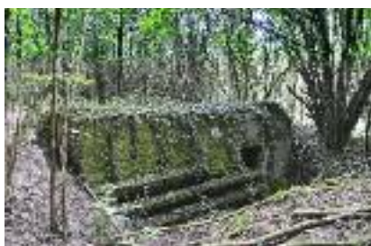
Casemate à Arry
